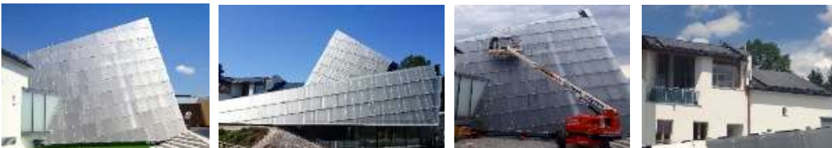
Pfarr- u. Gemeindezentrum Rif: ca. 500 m 2 Satiniertes Sicherheitsglas + Photovoltaikmodule
