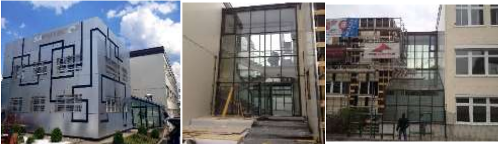
Fa. Sapotec Salzburg: Glasfassaden, Wintergarten, Glasdach über Haupteingang
